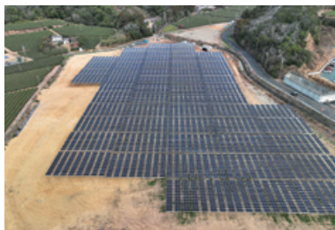
太陽光パネル
