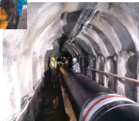
トンネル内配管点検
