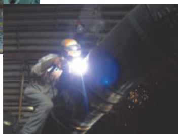
傾斜管での溶接施工
