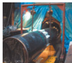
ガス配管の挿入風景
