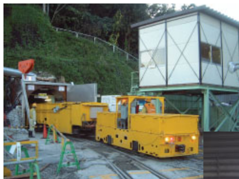
輸送導管建設現場（由比トンネル東坑口）
