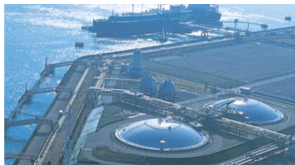
清水エル・エヌ・ジー袖師基地
