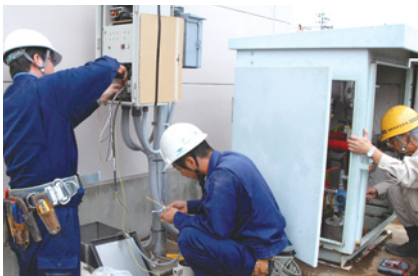
新システムの設置工事
