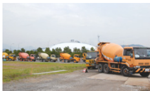
延べ5,000台以上のコンクリートミキサー車が使用されました。
