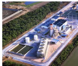
Eastern Power and Electric Company Limitedが運営する天然ガス焼き発電所
