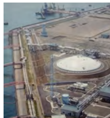
清水エル・エヌ・ジー袖師基地1号タンク完成
