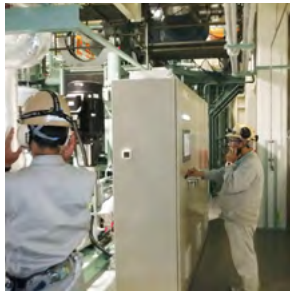
ガスエンジン試運転
