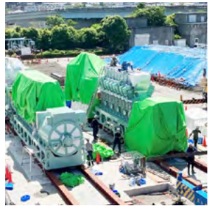
ガスエンジン設置工事①
