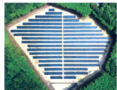
北関東エリアにおける高圧太陽光発電所(2024年7月運転開始)
