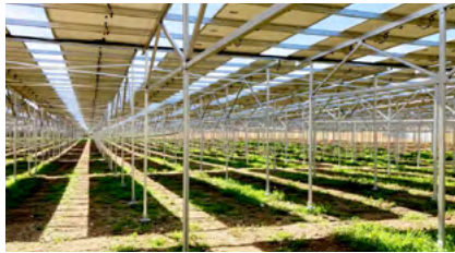
袋井市岡崎営農型太陽光発電所(静岡県) (2023年5月開所)
