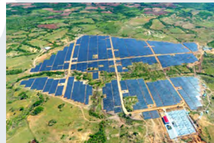
Myson発電所外観
