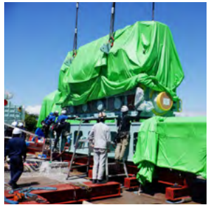
ガスエンジン設置工事②
