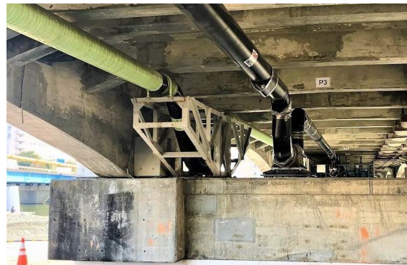
高圧パイプライン 架管入替／補強工事など
